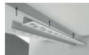
Encaixe o perfil sem o difusor no local.
