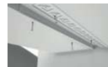
Parafuse o perfil no gesso conforme ilustração.
