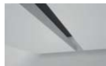
Abrir o gesso com a largura adequada.
